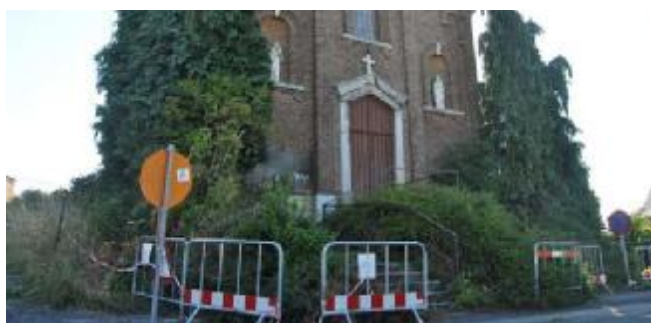
Aujourd'hui, des barrières interdisent l'accès à la chapelle. Une nouvelle vie s'offre à elle.
