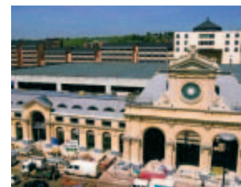
La dalle de la gare ■ B.A.
